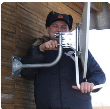
Смещая край антенны шагами по 1—3 см в «секторе поиска» сначала в одну сторону, затем в другую, продолжите поиск спутника вокруг ожидаемого направления на него.
